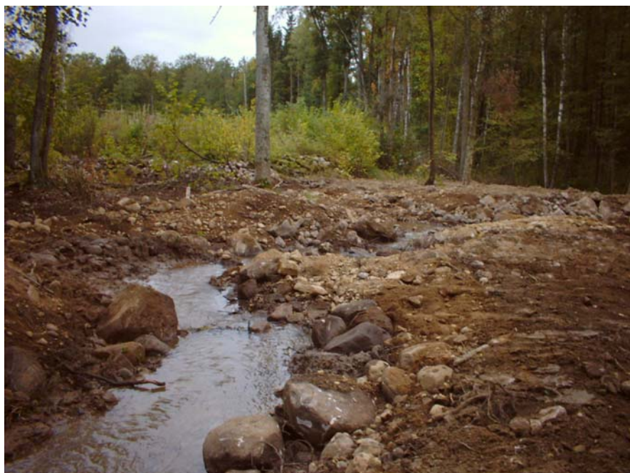
Färdigställd fiskväg. Stor vikt har lagts vid att efterlikna åns naturliga karaktär.
