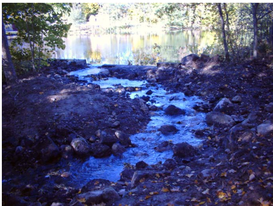
Färdigställd fiskväg. Stor vikt har lagts vid att efterlikna åns naturliga miljö.
