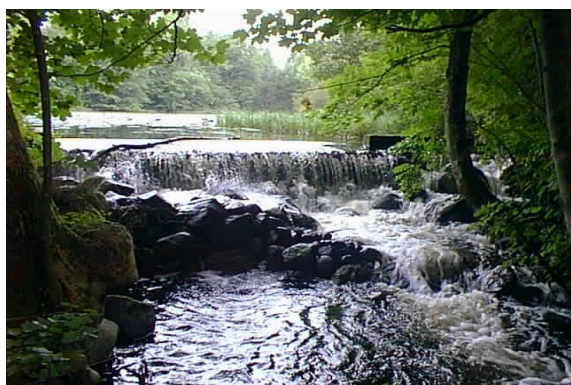
Före: Överfallet i kvarndammens sydöstra hörn är den enda vägen att ta sig uppströms i Kvesarumsån. Dämmet hade ett fall på ca 1.5 m.
