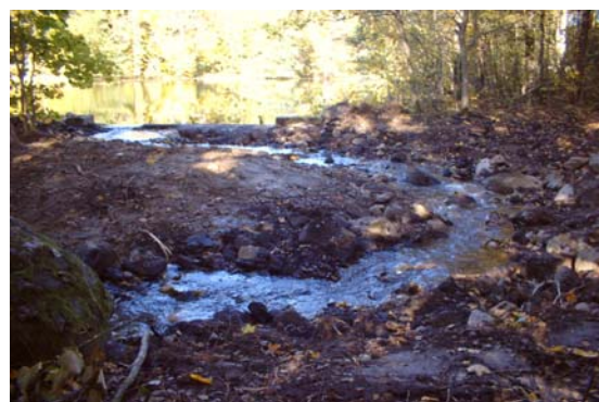
Efter: Fiskvägen färdigställd. Fallet har jämnats ut i den nya bäckfäran. Och fisk kan obehindrat passera.
